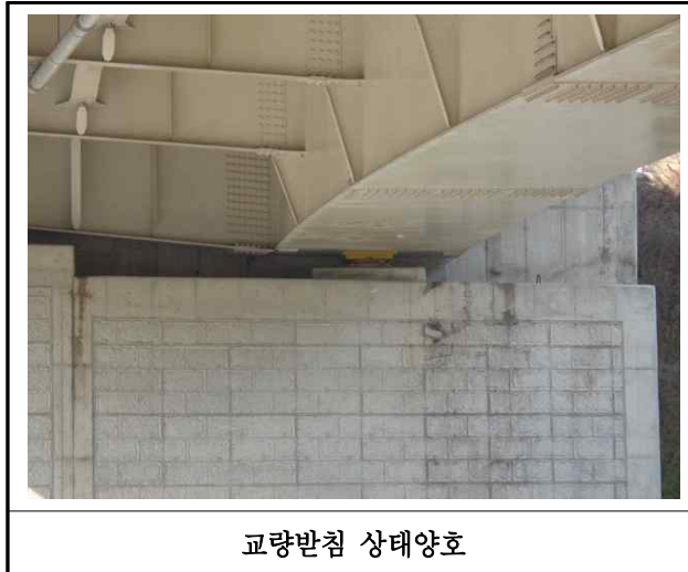
【사진 15.3.11】 교량받침 손상현황
