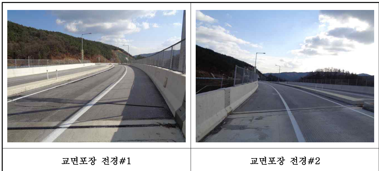
【사진 15.3.16】 교면포장 전경
