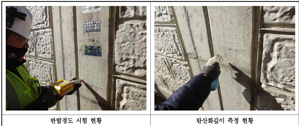
【사진 15.4.1】 콘크리트 내구성조사 현황
