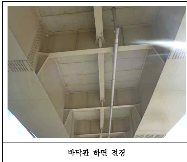
【사진 15.3.2】바닥판하면 전경
