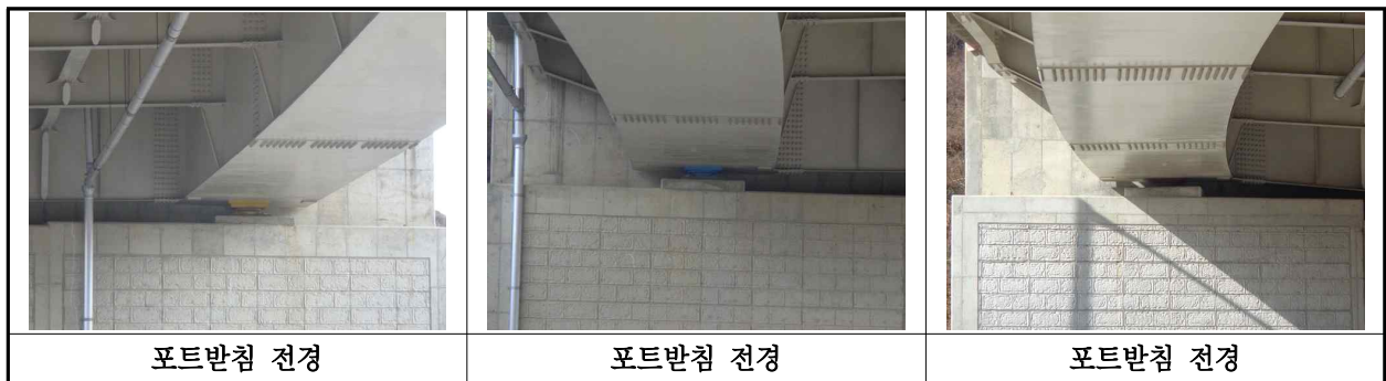
【사진 15.3.10】 교량받침 전경
