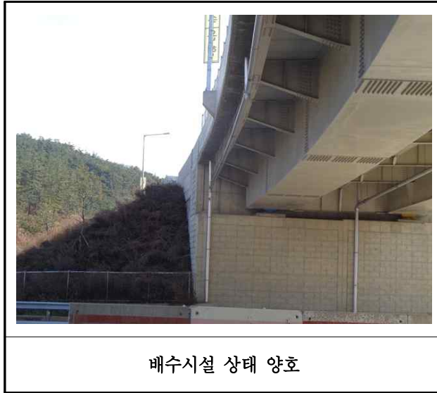
【사진 15.3.19】 배수시설 손상현황
