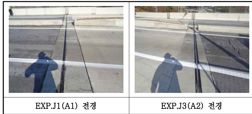
【사진 15.3.13】 신축이음장치 전경
