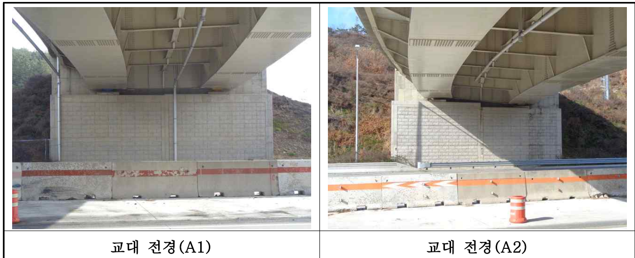
【사진 15.3.8】 교대 전경
